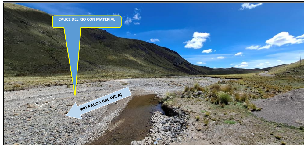
FIGURA 1 y 2 : TRAMO CRÍTICO EN EL RÍO PALCA, EN EL SECTOR PALCA, DISTRITO DE PALCA, PROVINCIA DE LAMPA- PUNO. NOTESE, LA ACUMULACION DE MATERIAL SEDIMENTADO EN EL CAUCE, QUE REQUIERE SER ELIMINADO PARA REESTABLECER LA SECCION HIDRAULICA DE LA CAJA DEL CAUCE EN ESTE SECTOR.
